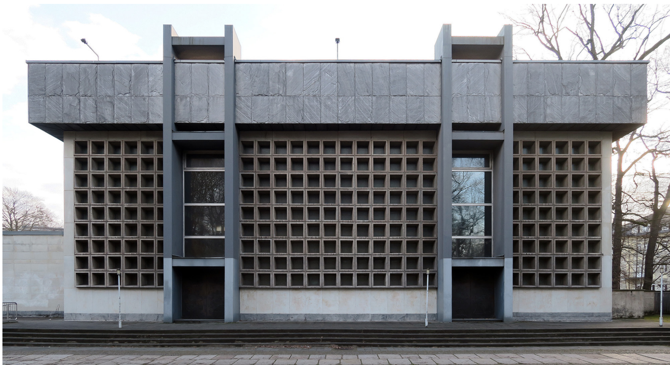
Probsteikirche, Leipzig. Inzwischen Abgerissen. Foto: Martin Maleschka, 2015
