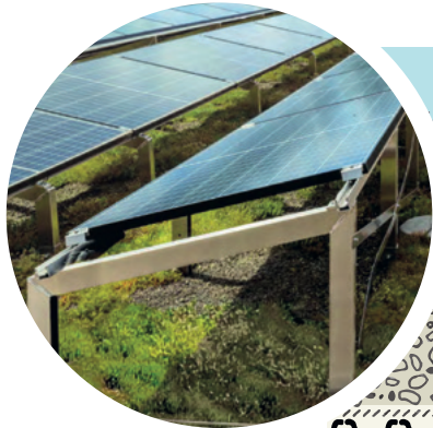
PV-Module, aufgeständert
